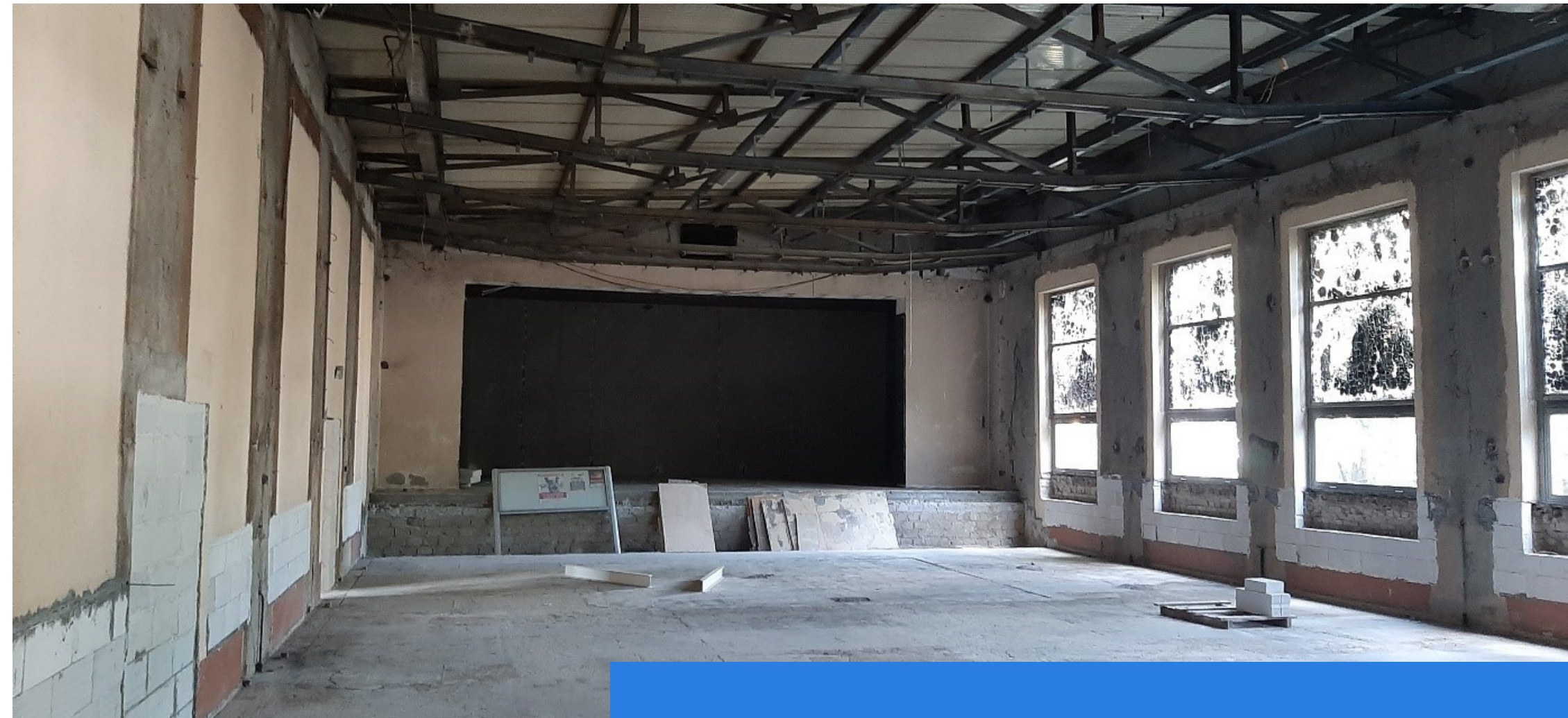
Obiekt przed remontem
